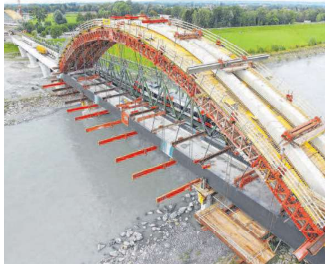
Erst im Jahr 2012 wurde die Rheinbrücke für die Bahn neu gebaut. Sie soll eingleisig bleiben, das sei kein Problem, sagt das Land.
